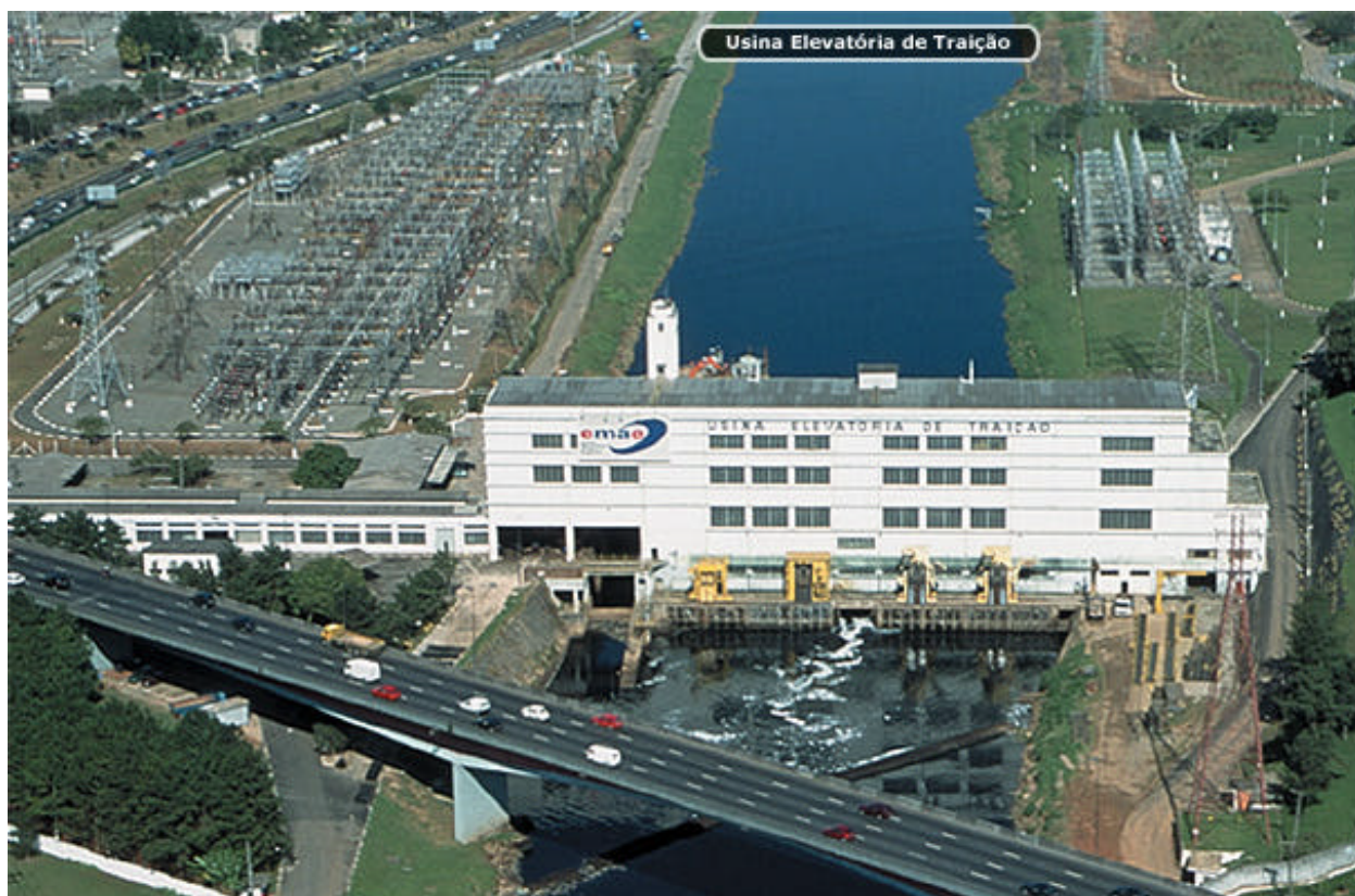
USINA ELEVATORIA DE TRAIÇÃO - UNIDADE IV
