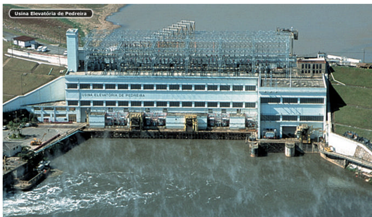
USINA ELEVATÓRIA DE PEDREIRA – UNIDADES VII E VII
