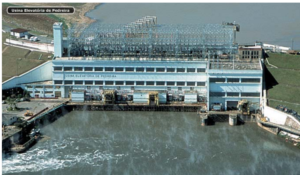
USINA ELEVATÓRIA DE PEDREIRA – UNIDADES VII E VIII
