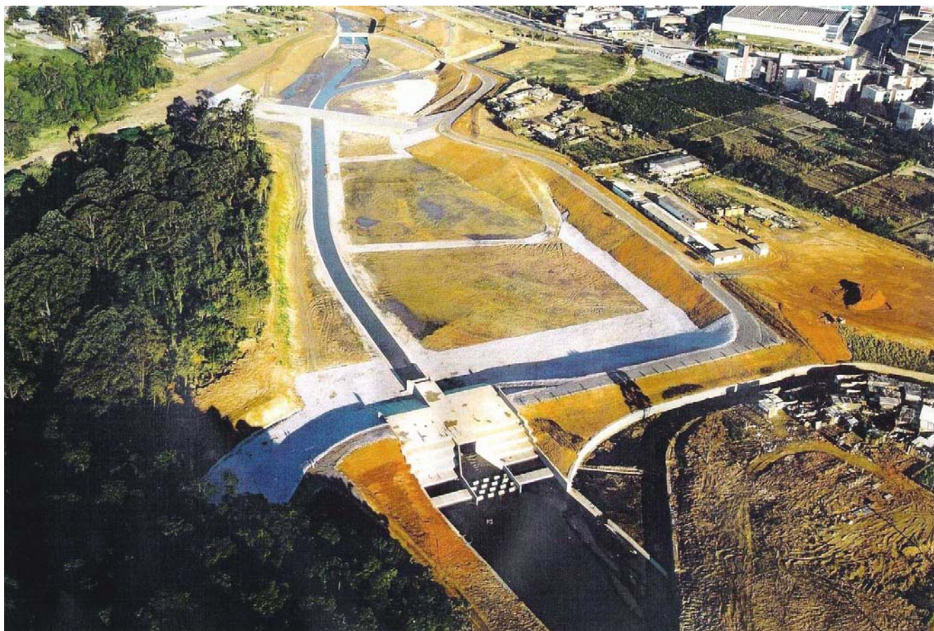
RESERVATÓRIO ARICANDUVA III
